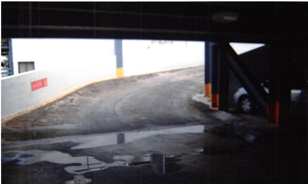
EDIFICIO DE PARQUEO. VISTA INTERIOR DE LA PROPIEDAD.
