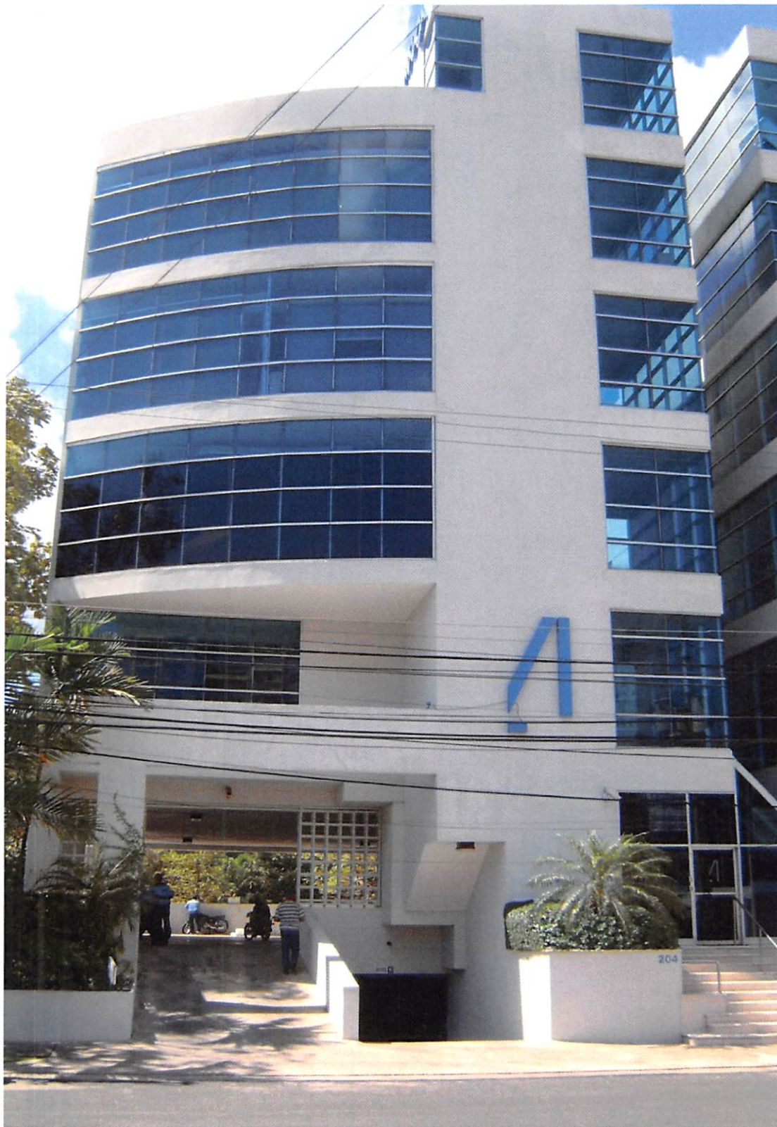
DESCRIPCIÓN DE LA PROPIEDAD. EDIFICIO MALAGA II.
