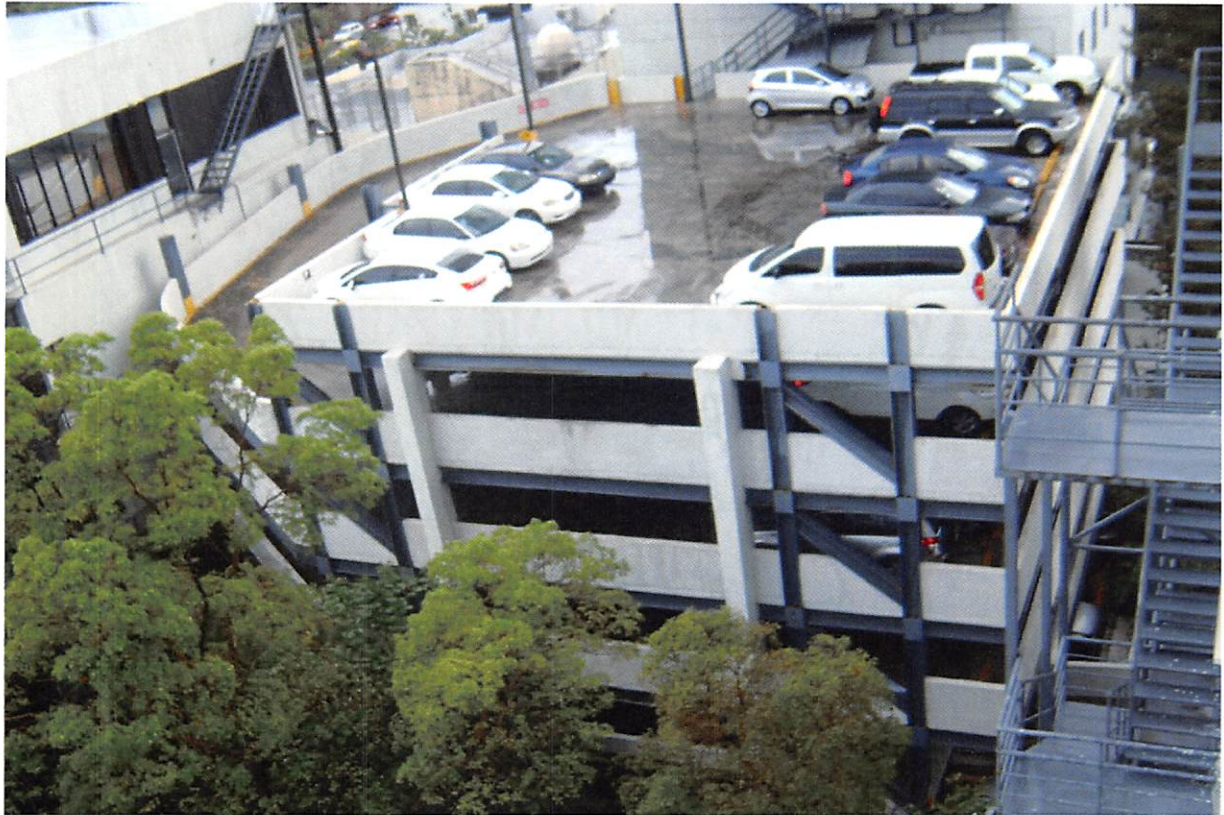
EDIFICIO DE PARQUEO. VISTA DESDE AZOTEA DEL EDIFICIO MÁLAGA IV.
