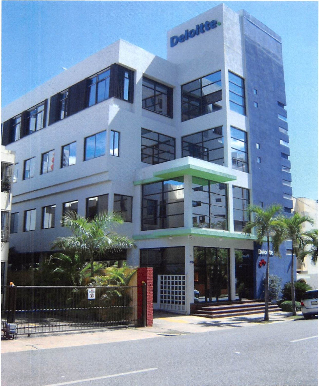
DESCRIPCIÓN DE LA PROPIEDAD. EDIFICIO MÁLAGA I.
