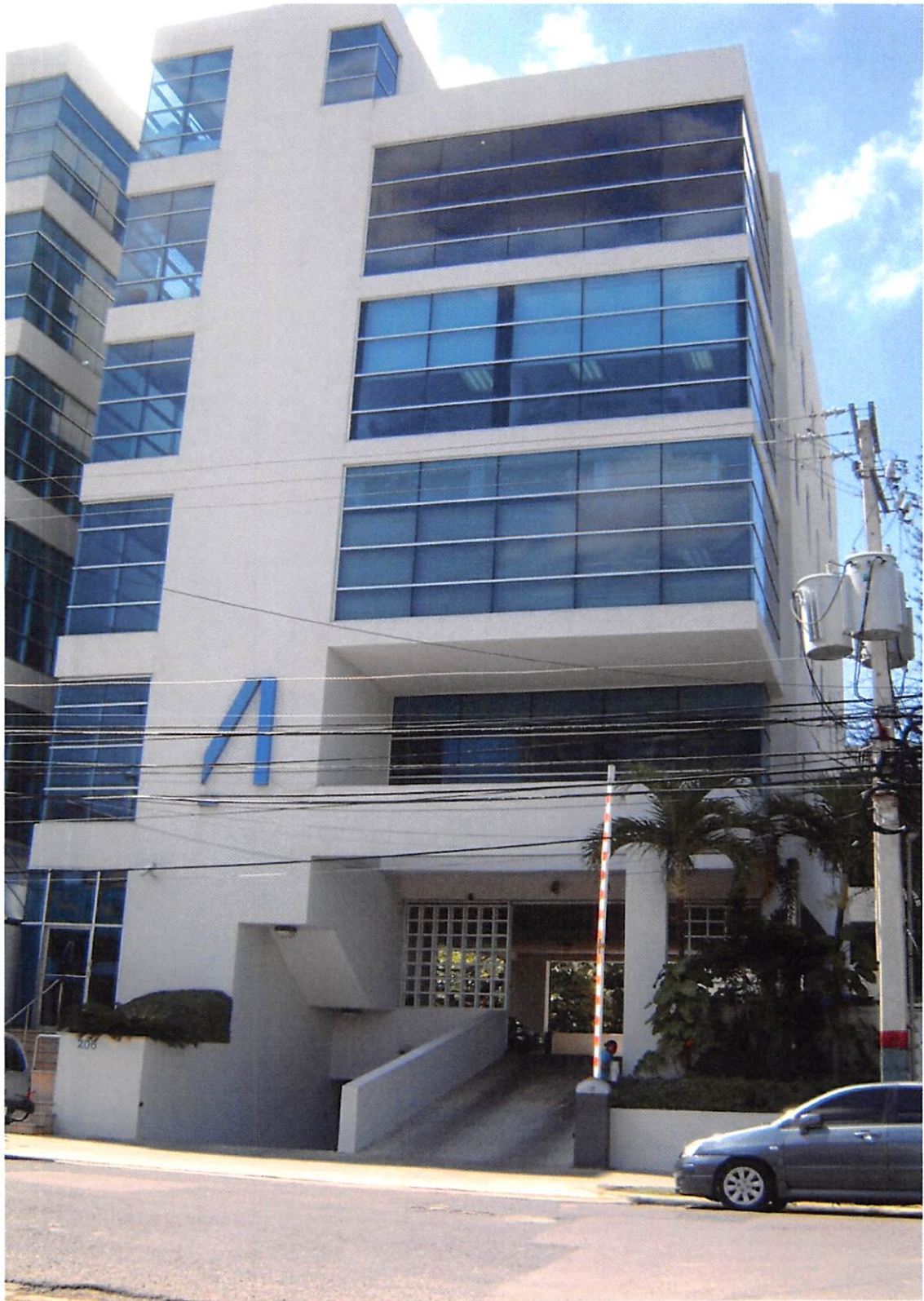
DESCRIPCIÓN DE LA PROPIEDAD. EDIFICIO MÁLAGA III.
