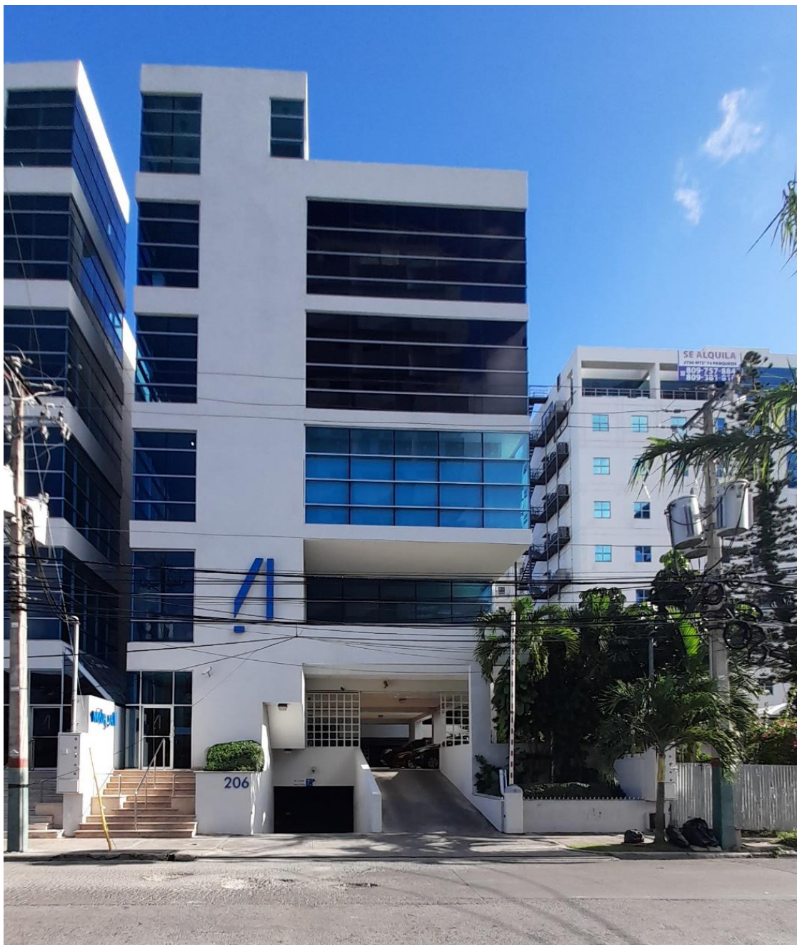
DESCRIPCIÓN DE LA PROPIEDAD. EDIFICIO MÁLAGA III.
