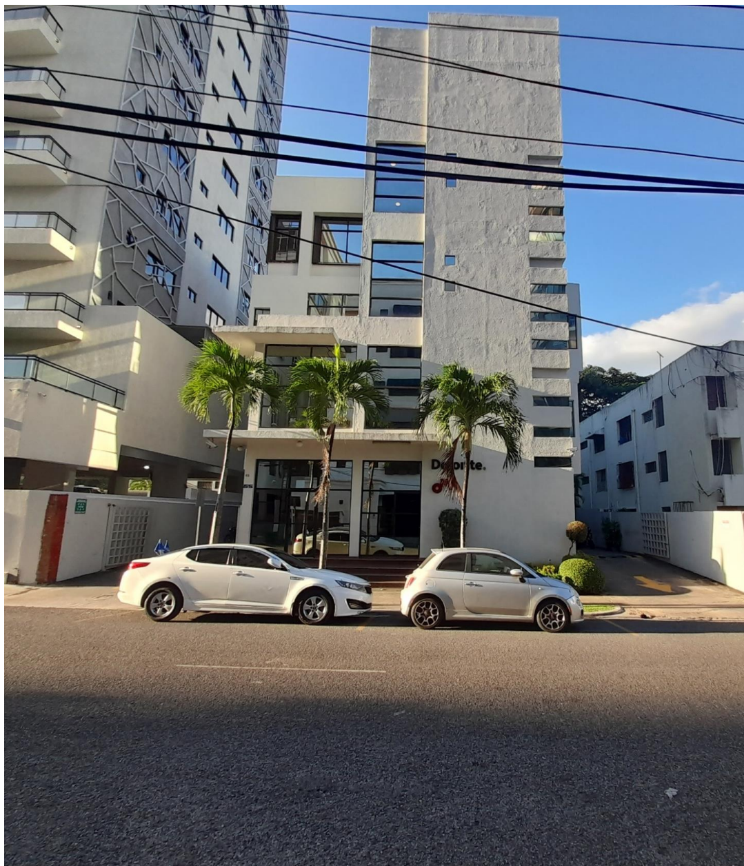
DESCRIPCIÓN DE LA PROPIEDAD. EDIFICIO MÁLAGA I.
