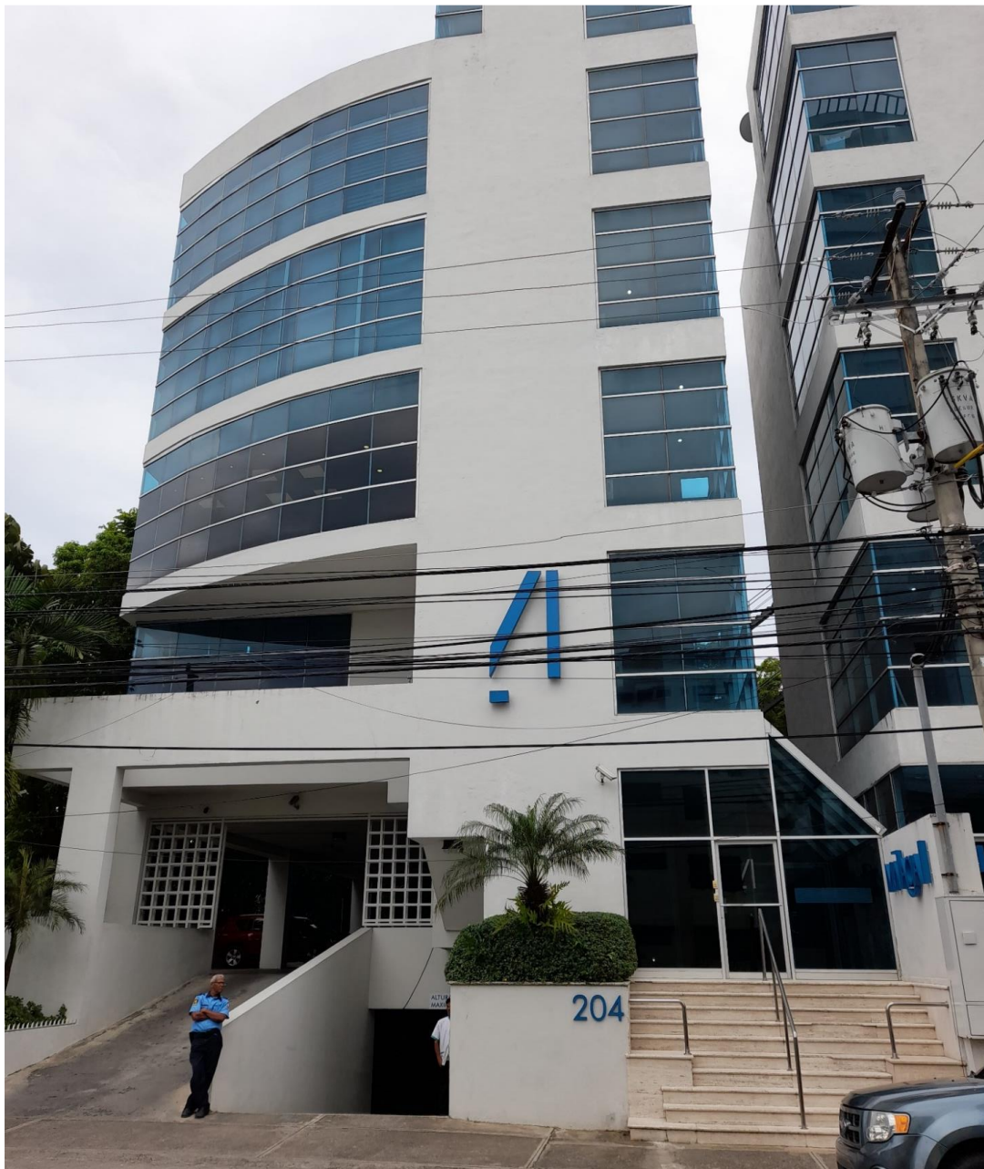
DESCRIPCIÓN DE LA PROPIEDAD. EDIFICIO MÁLAGA II.
