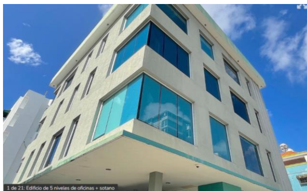
1 de 21. Edificio de 5 niveles de oficinas + sotano
