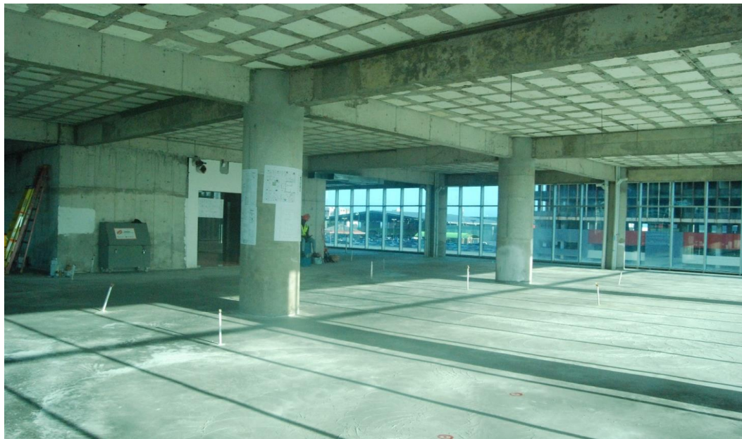
DESCRIPCIÓN DE LA PROPIEDAD. 5TO. NIVEL LOCAL No. 501.
